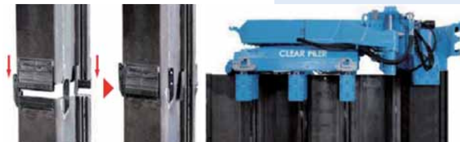
4 a-c Aanbrengen damwanden
