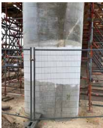
6a Keimen betonoppervlak Beeld: Joost Vreugdenhil
