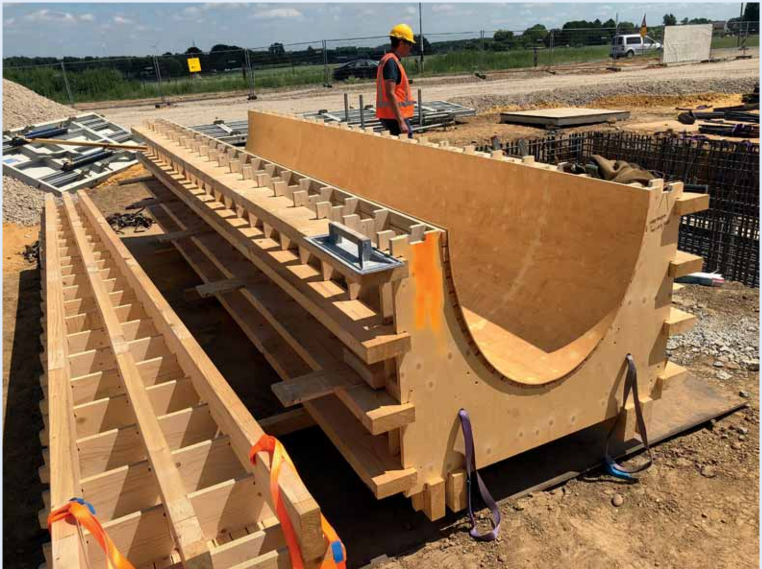
↑ ↓ 7a en 7b Voor het storten van alle pijlers volstond één houten mal
