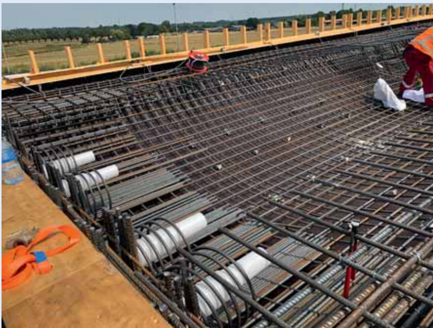
9 De bekisting en wapening van een brugdeel met doorvoeren voor de voorspanning.
