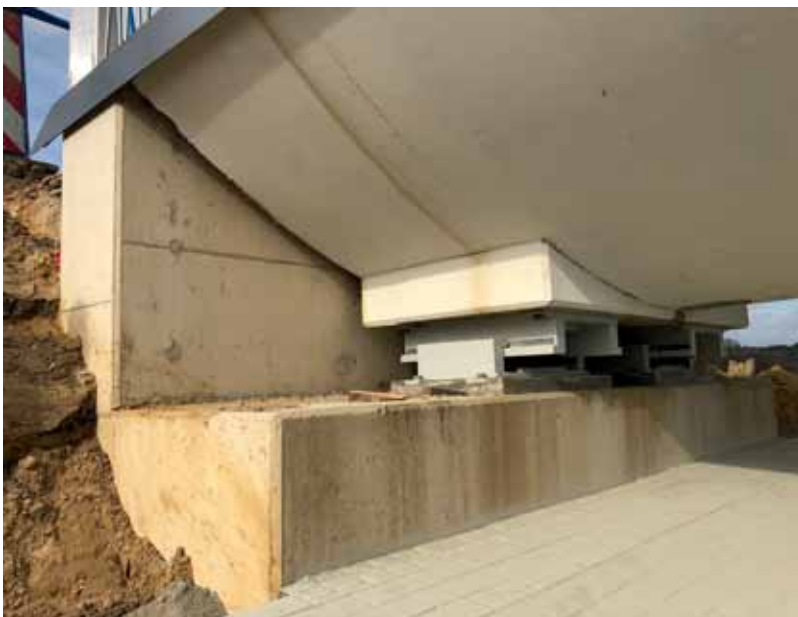
11 Oplegging t.p.v. landhoofd met fixatie in dwarsrichting
