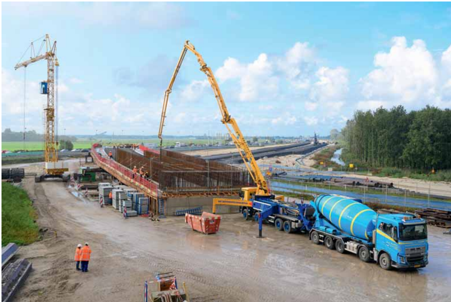
↑ ↓ Het storten van de onderrand van de kokerligger (KW 21) © R. Keus
