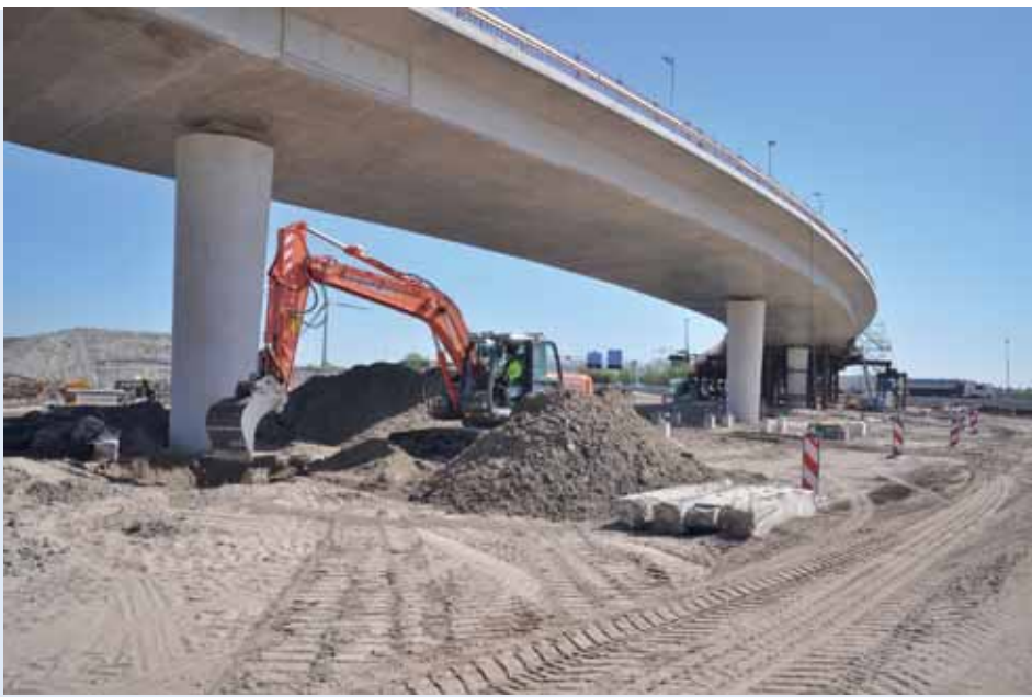
2 Plaatligger KW 20 in knooppunt Hofvliet
