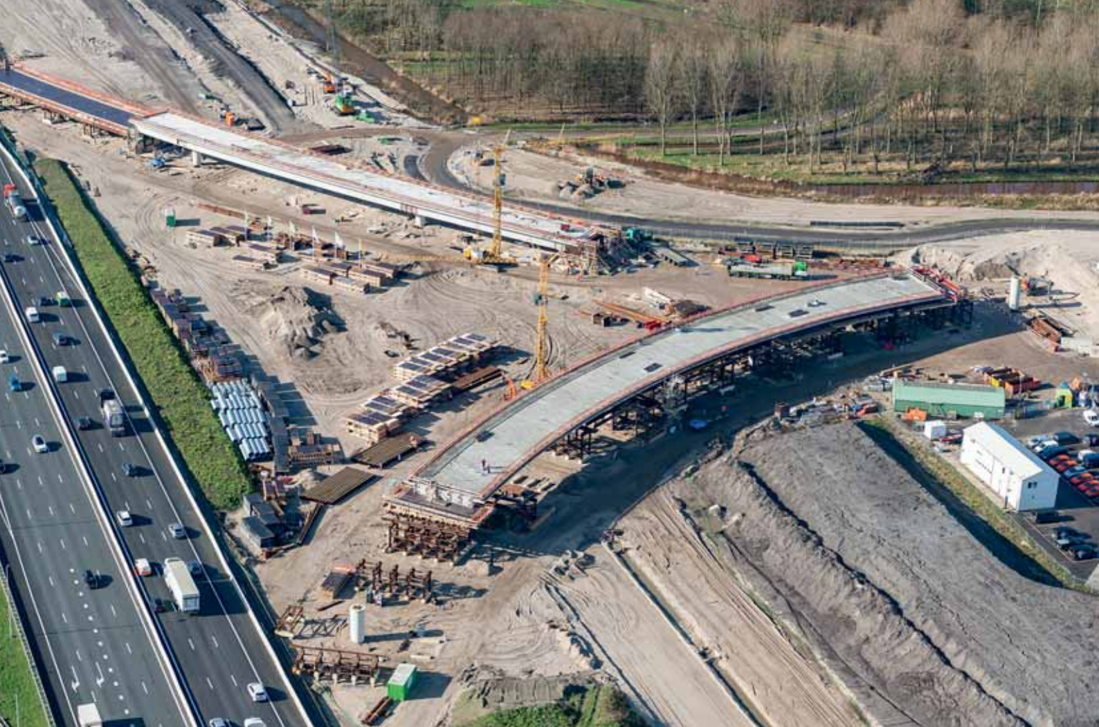
1 Bovenaanzicht knooppunt Hofvliet (A4/N434), gezien in de richting Den Haag
