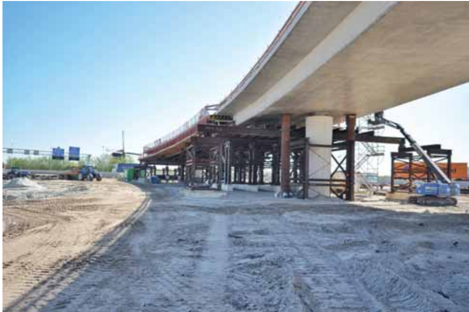
5 plaatligger KW 20 in knooppunt Hofvliet
