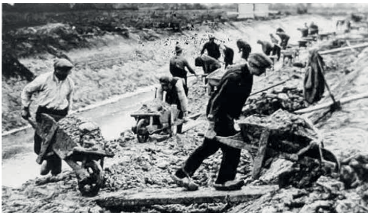
6 In het kader van de werkverschaffing werden delen van het kanaal met de hand uitgegraven. Men moest 60 uur per week werken voor 20 gulden; © Heitling en Jensen
