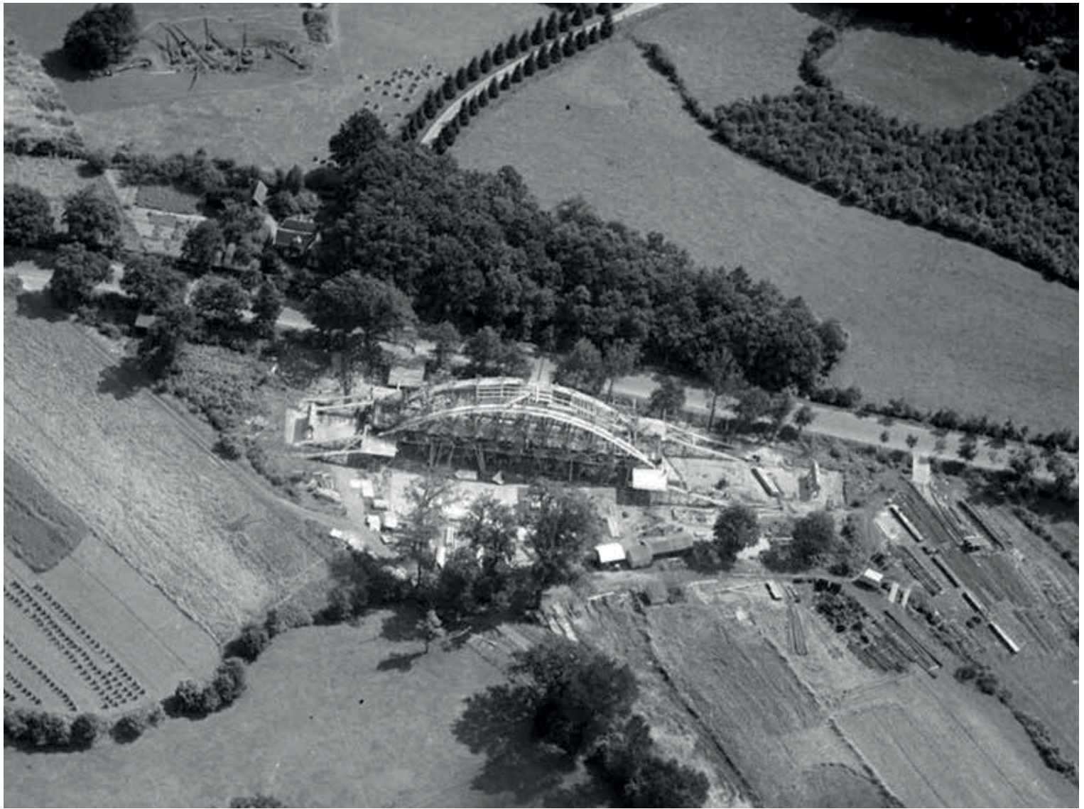
3 Aanleg van een van de betonnen boogbruggen in het droge © Rijkswaterstaat
