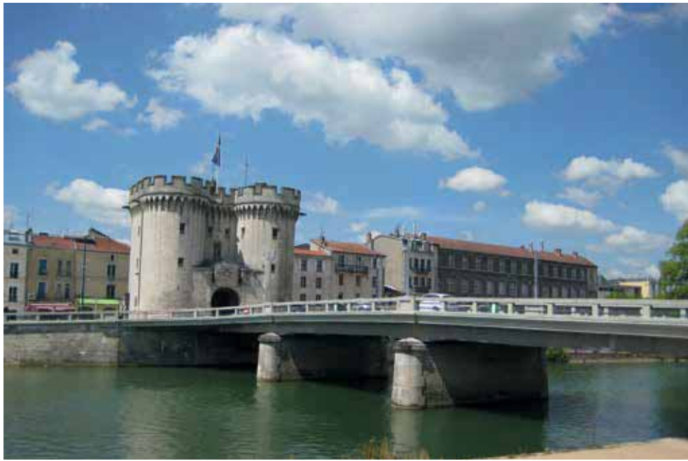
3 Verdun, Pont Chaussée. foto: F. Remery
