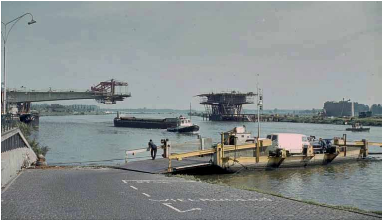
7 Vrije uitbouwbrug Wessem in aanbouw.
