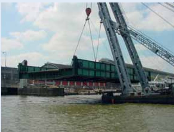
7 Transport in 2000 van de Oostertoeegang en heftorens naar de opslag © Archief Gemeente Amsterdam
