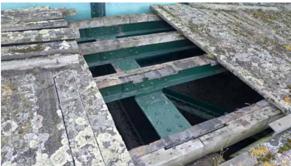
19 Hergebruik stalen val, dwarsdragers en te vervangen voetgangersdek © Royal HaskoningDHV, 2016
