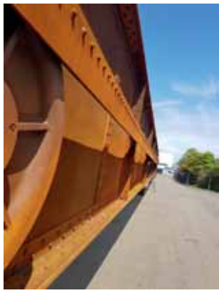
24 Reparatie klinknagels en schetsplaten © Gebr. Beentjes GWW, 2019
