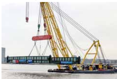
23 Transport vanaf de opslag naar de werkplaats aan de overzijde van het IJ © Gebr. Beentjes GWW, 2019
