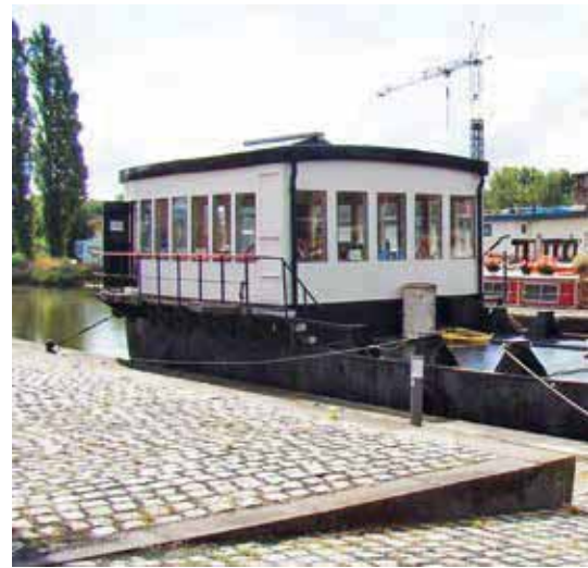
7 Ponton van de schipbrug met het machinehuis voor de lieren en de opleggingen voor de brug.
