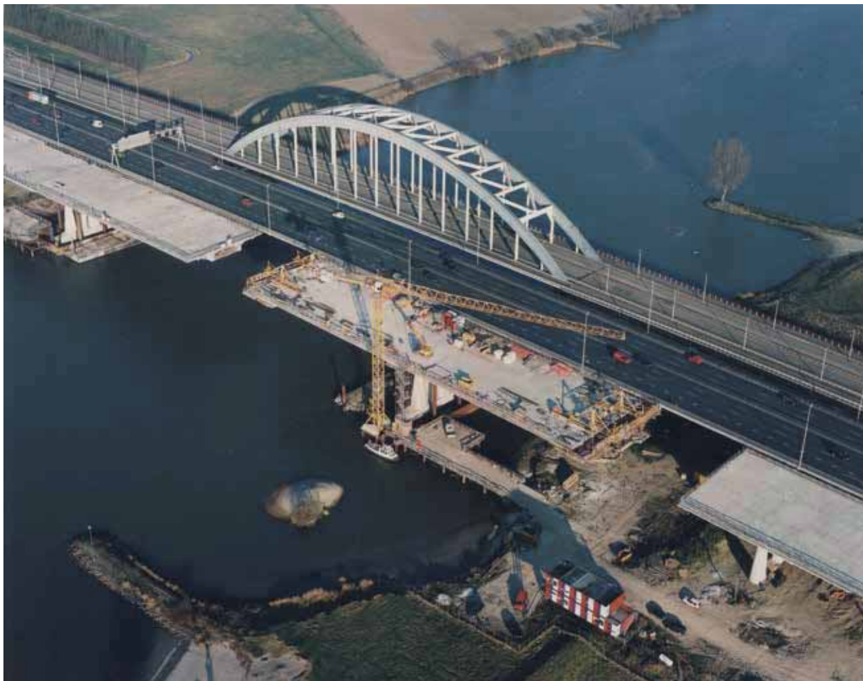
13 Bouw van de tweede betonnen brug als uitbouwbrug bron: archief Nederlandse Bruggenstichting
