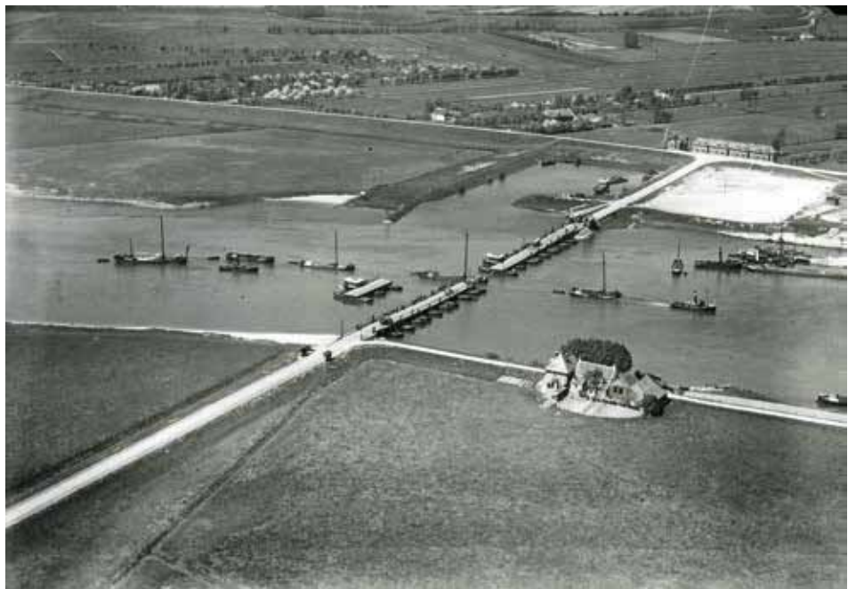
4 Overzicht schipbrug. bron: archief Nederlandse Bruggenstichting
