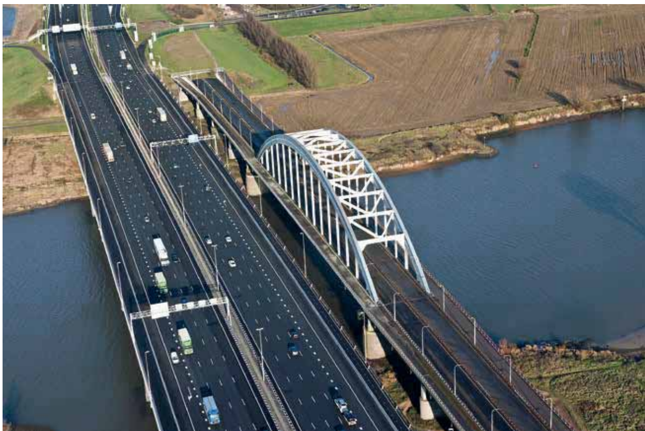
14 De nieuwe betonnen bruggen naast de oude boogbrug bron: archief Nederlandse Bruggenstichting
