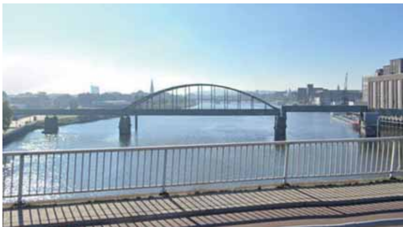
1 Stalen spoorbrug over de Maas
