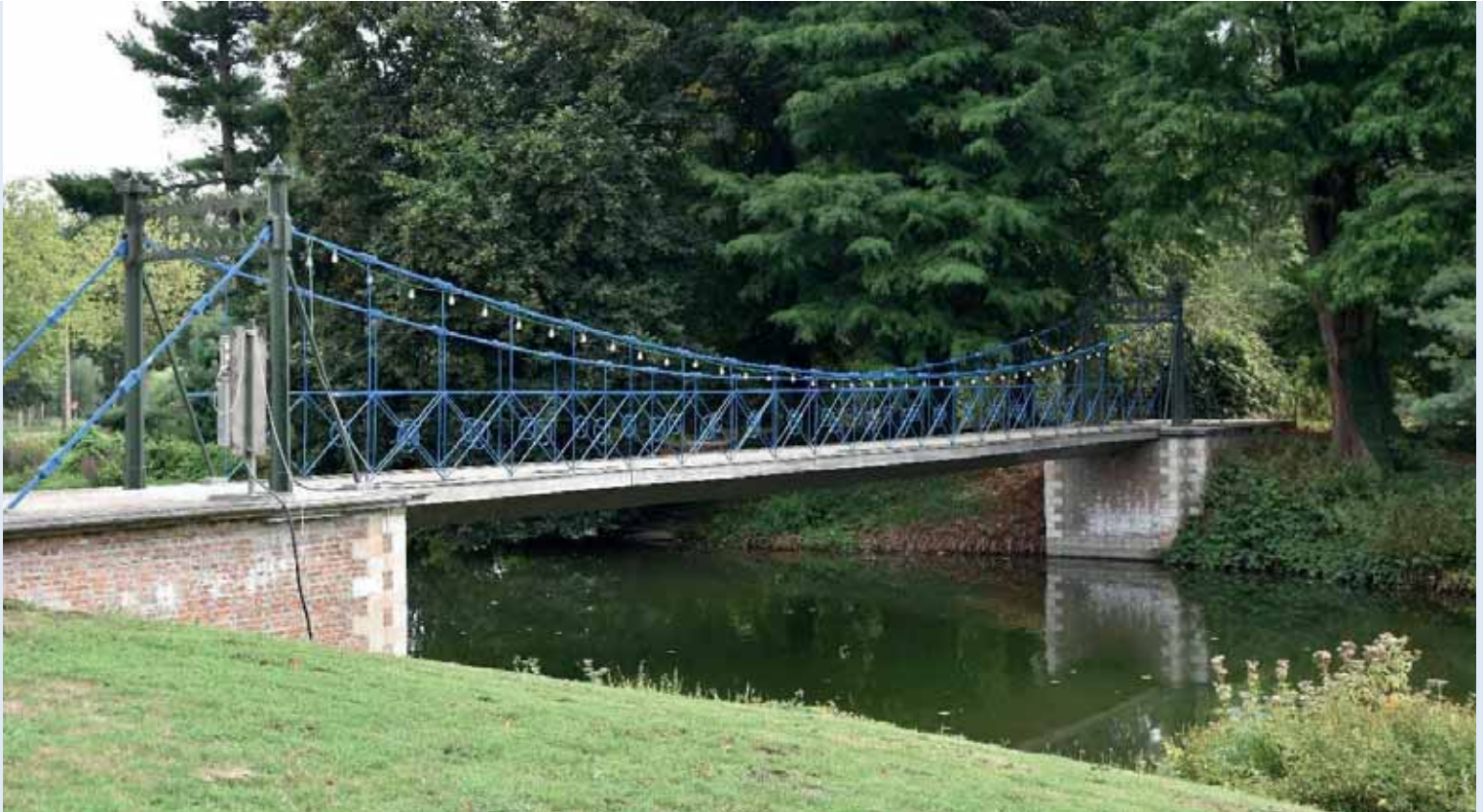
3 Brug over de Parkvijver kasteel Wissekerke
