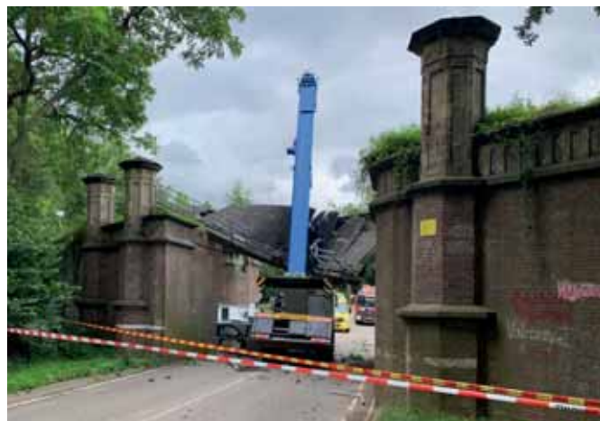
2 Herstel spoorbrug in voormalige spoorlijn Maastricht-Hasselt ©Track '88
