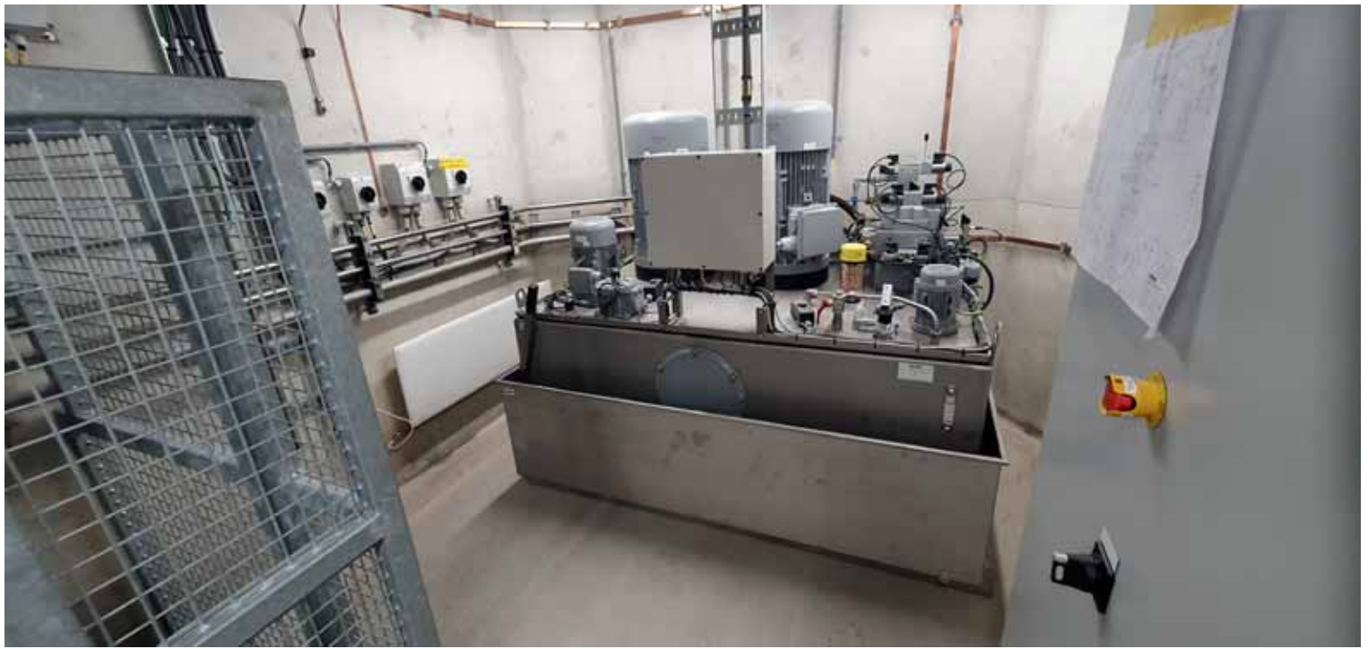
17 hydrauliekunit in de kelder
