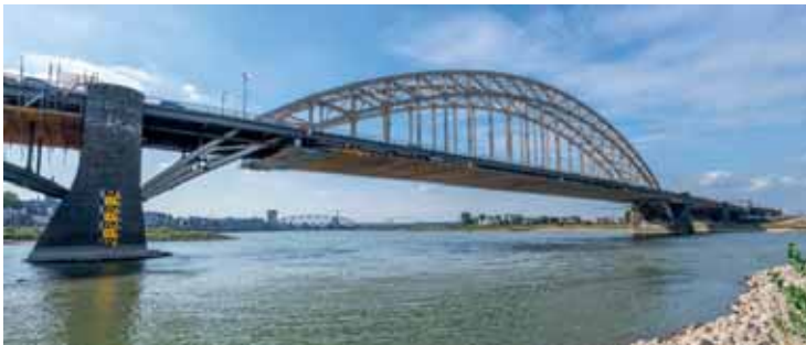
Bij de opening in 1936 was de Waalbrug in Nijmegen de boogbrug met de grootste overspanning van Europa: 244 meter!
