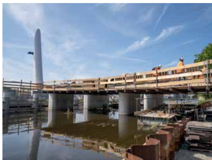
13 Ondersteuning bekisting uitwaaiend dek met dubbele UNP-liggers
