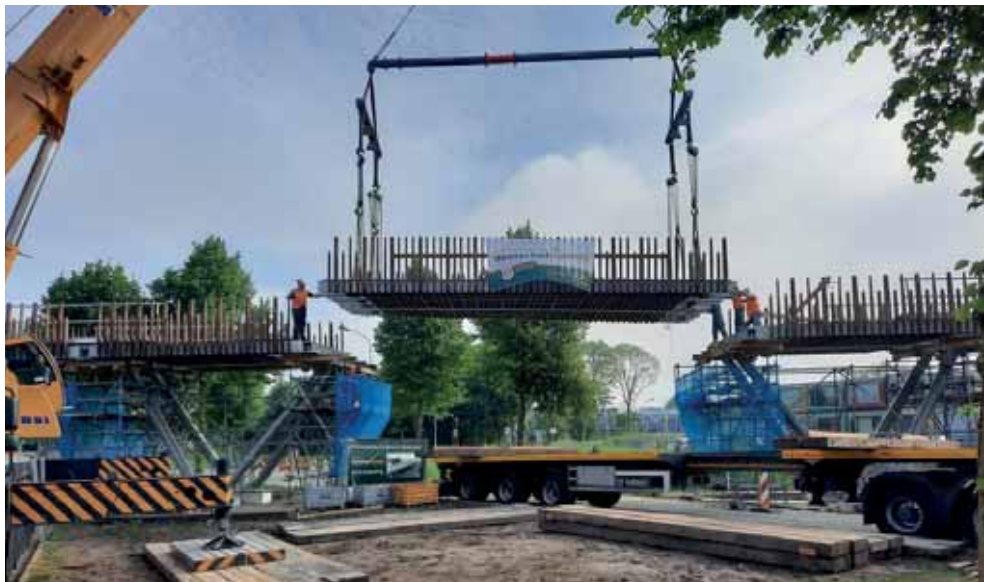
5. Laatste brugdeel wordt ingehesen
