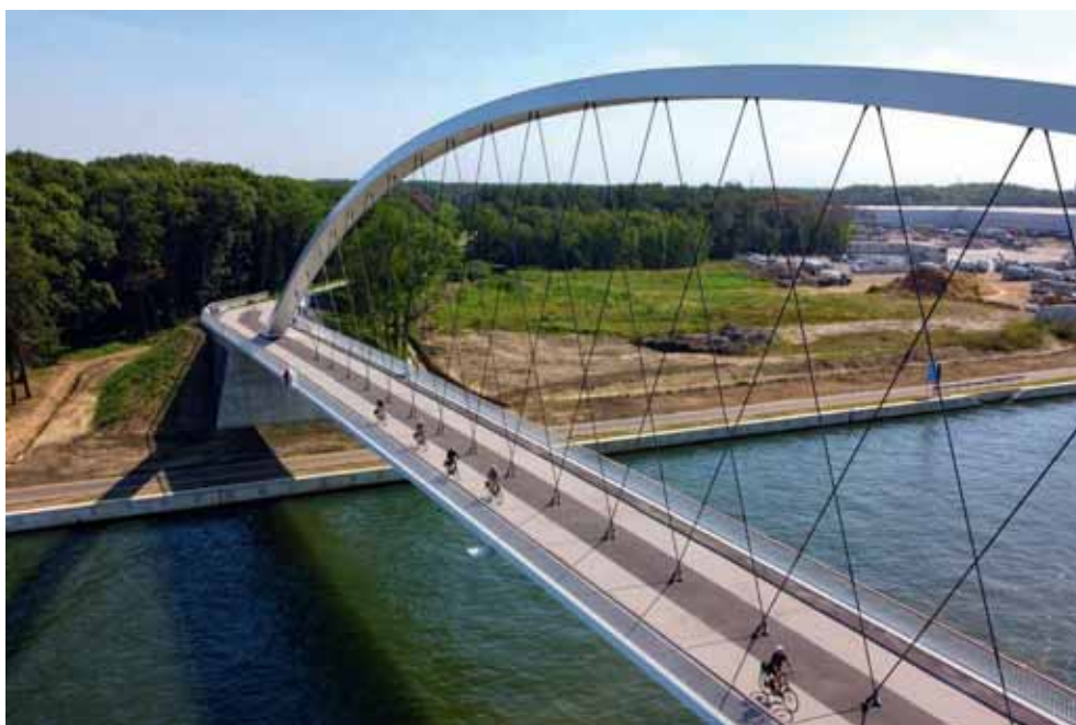
6 Fietsbrug Tessenderlo Albertkanaal
