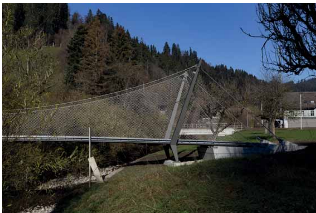
5 De brug heeft met een totale lengte van 25,8 m en ligt in het verlengde van de weg Himmelhausmatte.
