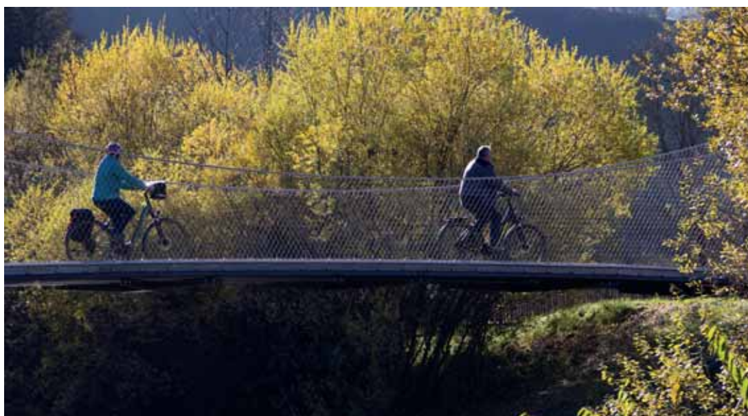
6 Voor inwoners van de gemeente Trubschachen biedt de brug een directere verbinding met het station. Er is nu een veilig voet- en fietspad, vooral voor de schoolkinderen van het dorp.
