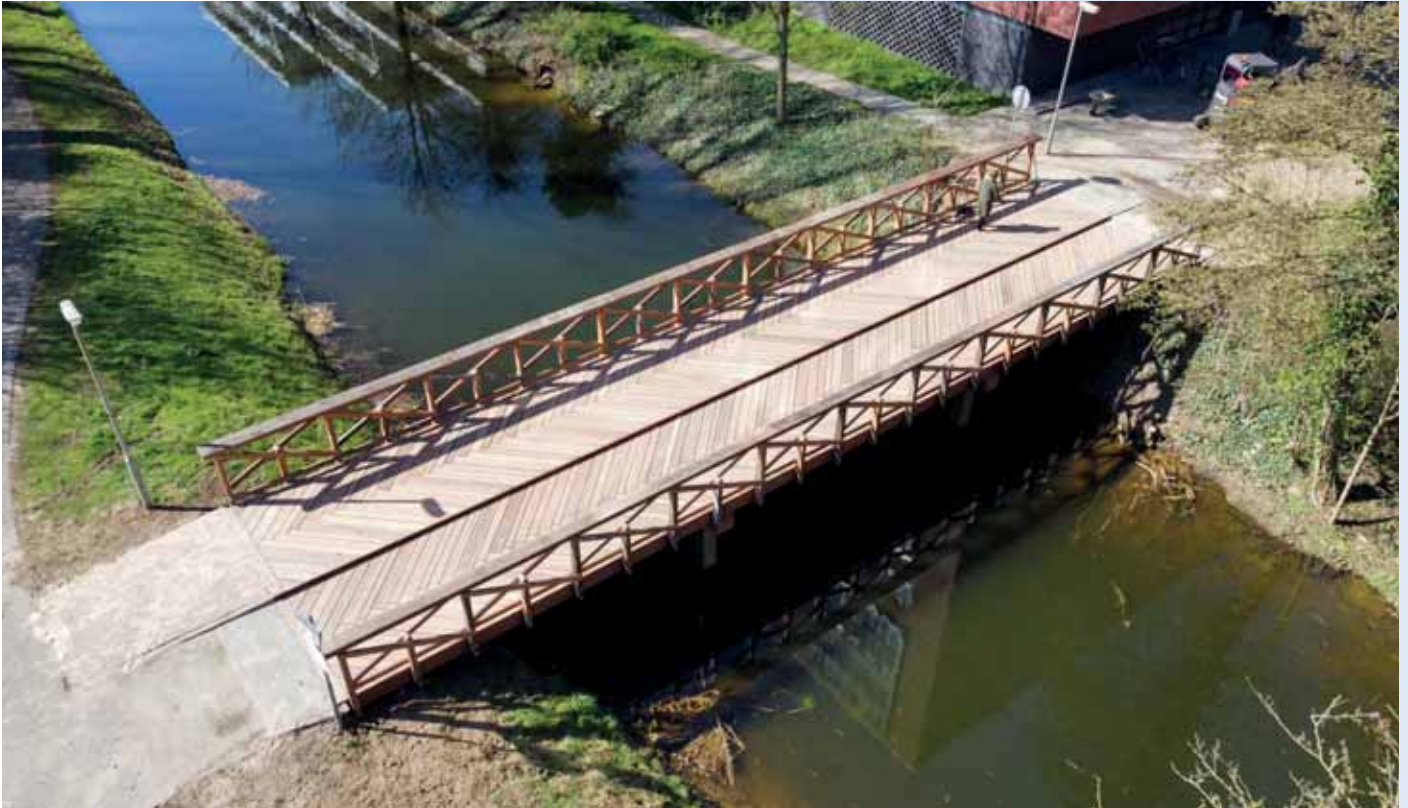
Circulaire brug Immerloopark te Arnhem
